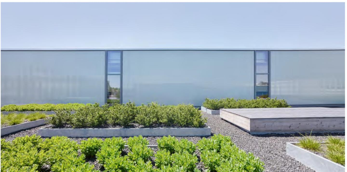
Für die Verglasung kamen knapp 500 Quadratmeter des Sonnenschutzglases SGG COOL-LITE SKN 165 II und gut 1.800 Quadratmeter der gläsernen Paneele mit EMALIT auf extra-weißem SGG DIAMANT Glas zum Einsatz.
